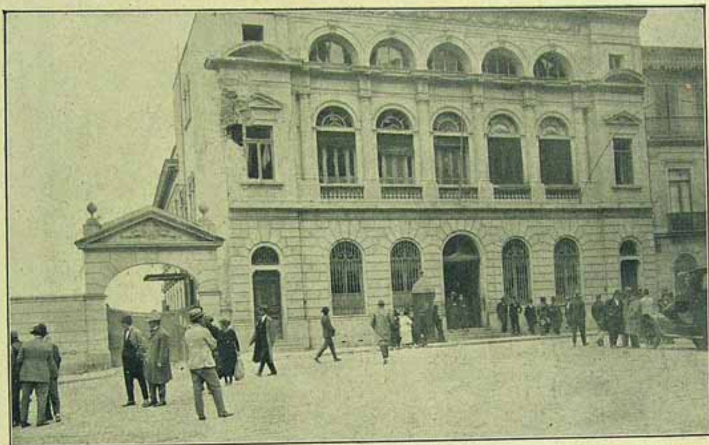
Edifício da Secretaria da Justiça, atingido por uma granada lançada contra o mesmo pelas forças em rebelião.
