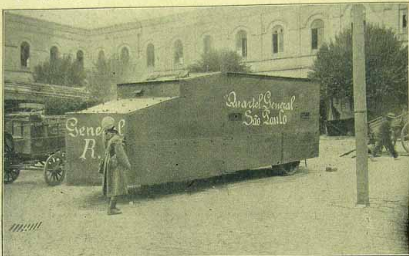
No Quartel da Luz. Carro blindado feito com chapas de aço, pelos revoltosos
