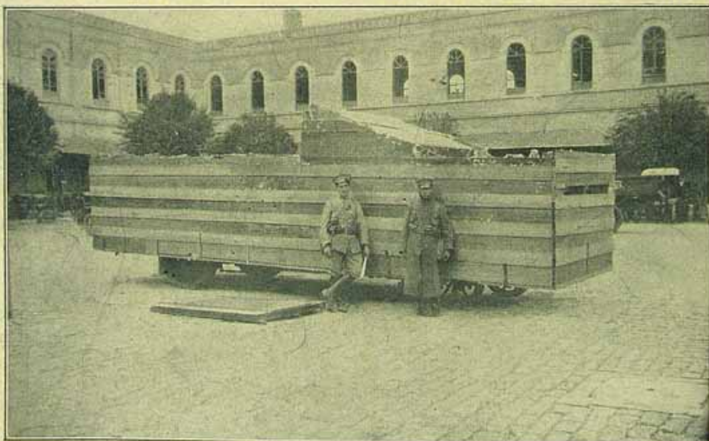
Outro carro blindado dos revoltosos, feito, desta vez, com taboas e areia. Não foi possível aos sediciosos fazer mover estes carros de assalto.
