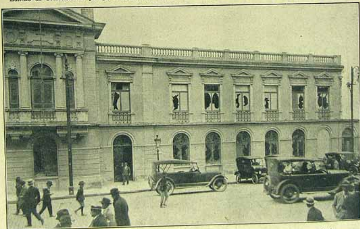
Estragos produzidos pela metralha dos revoltosos numa das alas do Palácio do Governo na cidade.
