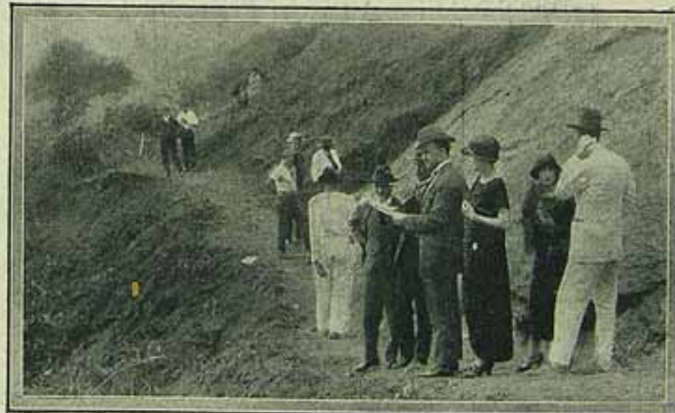
Quando se inauguravam, na semana passada, com a presença do Sr. prefeito, os serviços de abertura da avenida do morro de Santa Maria.
