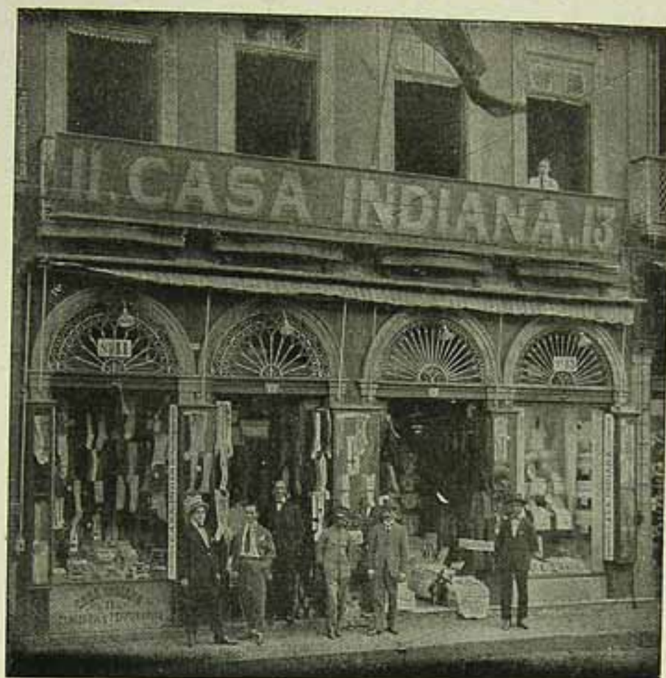
Casa Matriz na rua dos Andradas
