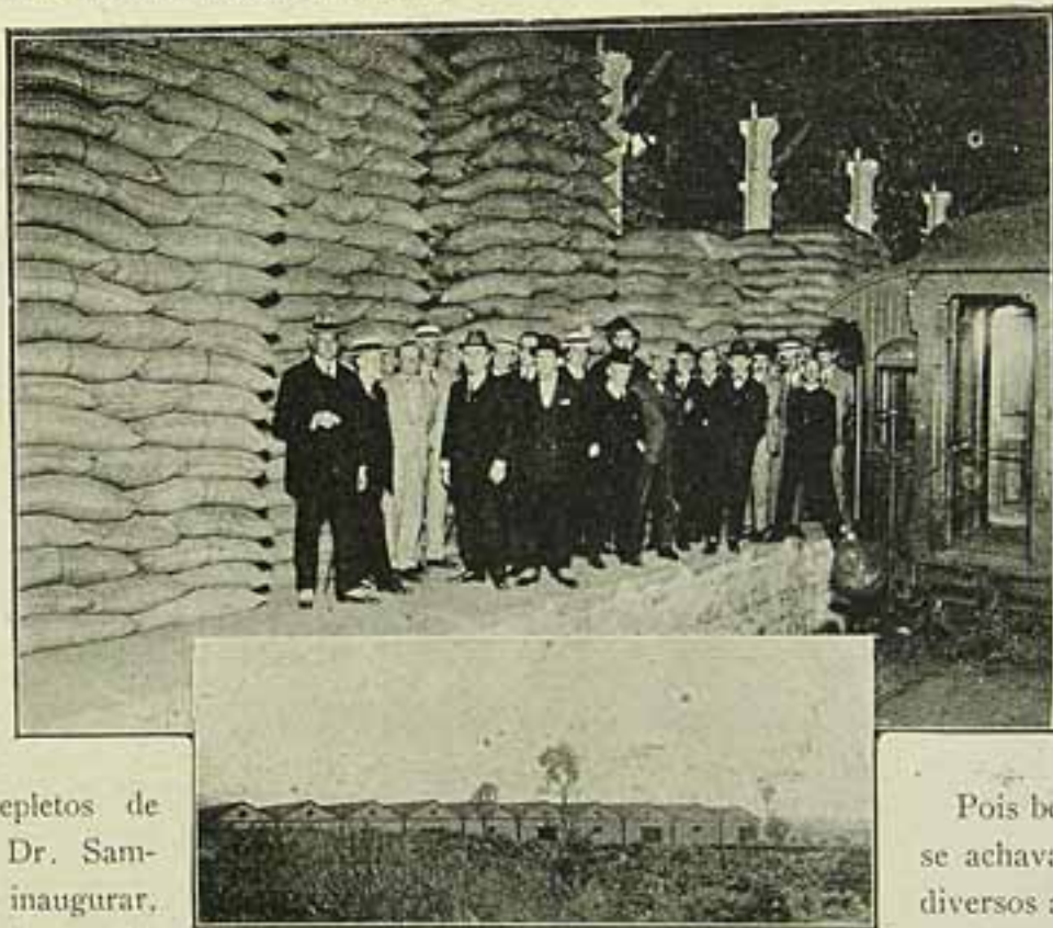
Em cima: Interior do Armazem de Campinas, vendo-se, entre outras pessoas, os Srs. Drs. Sampaio Vidal, ministro da Fazenda; Gabriel Ribeiro dos Santos, secretario da Agricultura do Estado de S. Paulo, e Gabriel Penteado. — Em baixo: Vista exterior dos Armazens Reguladores de Itirapina.
