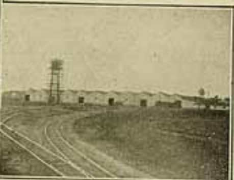
6) Vista geral dos Armazéns de Araraquara. — 7) Vista interior de um armazém em Rincão.
