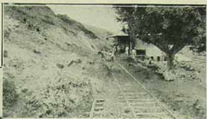
Bella vista de conjunto do Viaducto Retiro na E. F. Central do Brasil
