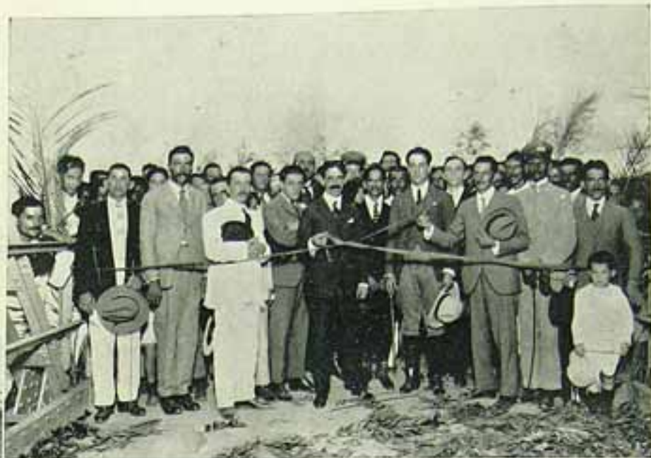
O Dr. Viçoso Jardim, Secretario Geral do Estado, inaugura uma ponte metallica sobre o Rio Macabú
