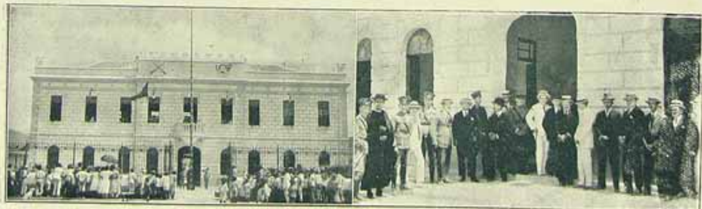
"O MALHO" NA CAPITAL DO PIAUHY — 1) Pavilhão central do quartel do 25º Batalhão de Caçadores, em Teresina, construído sob a fiscalização do engenheiro-militar capitão José Faustino da Silva. 2) No dia da entrega do edifício. Vê-se ao centro o governador do Estado, Sr. João Luiz, e outras altas autoridades.
