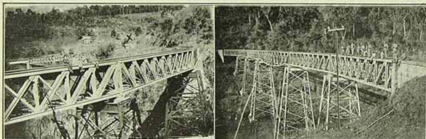
Dois pontes no trecho ferroviário Barro — Viaductos guarnecidos por força do Exército — Ponte sobre o rio Anta Manso.
