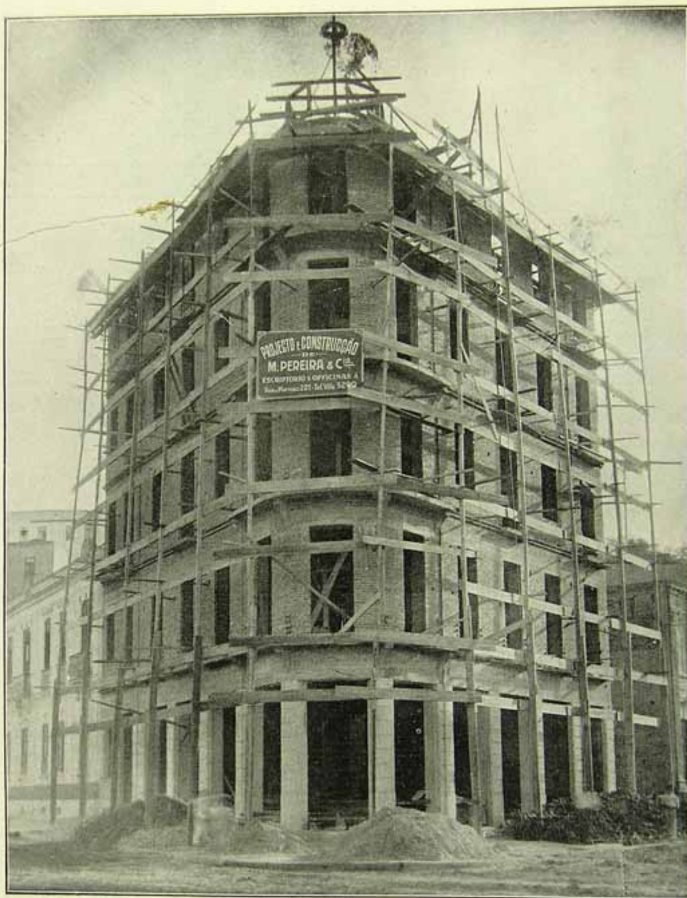
Photographia do esqueleto do edificio em construcção á Avenida Henrique Valladares ns. 139 e 141, por occasião do lançamento da cumieira, propriedade do Exmo. Sr. Antonio G. de Carvalho, um dos grandes industriaes e proprietarios desta Capital: Empreitada da firma Constructora M. Pereira & Cia. com Escriptorio á Avenida Rio Branco n. 117 — 3º andar. Telephone N. 2716. — Deposito Rua do Mattoso, 221. Telephone V. 5290 — Caixa Postal 1812.
