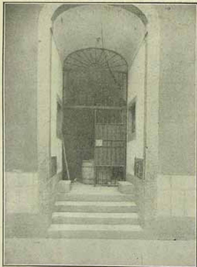
Sahida da 1ª galeria, para a qual dá o "mezzanino" do cubiculo 24, serrado pelo criminoso, e por onde o mesmo passou para ganhar a praça 15 de Novembro.
