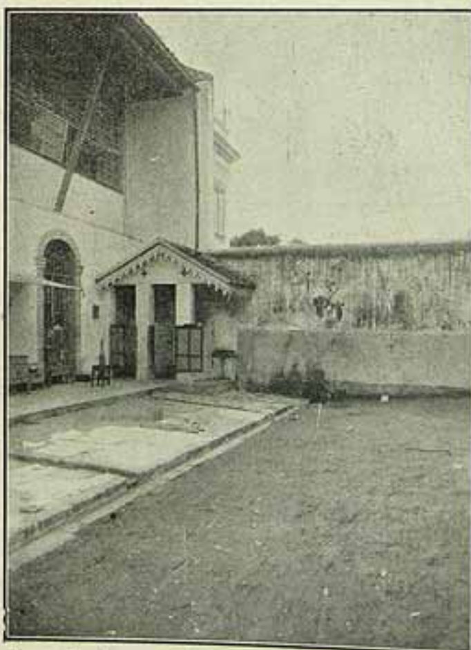
Muro interior, que divide as praças 15 de Novembro e 11 de Junho, que o criminoso transpoz para ganhar a casa da caldeira da cozinha.
