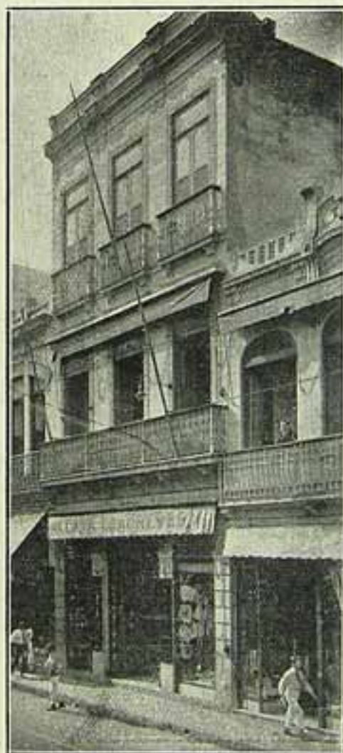
Fachada da "Casa Gonçalves", á rua Sete de Setembro, 165 e 167
