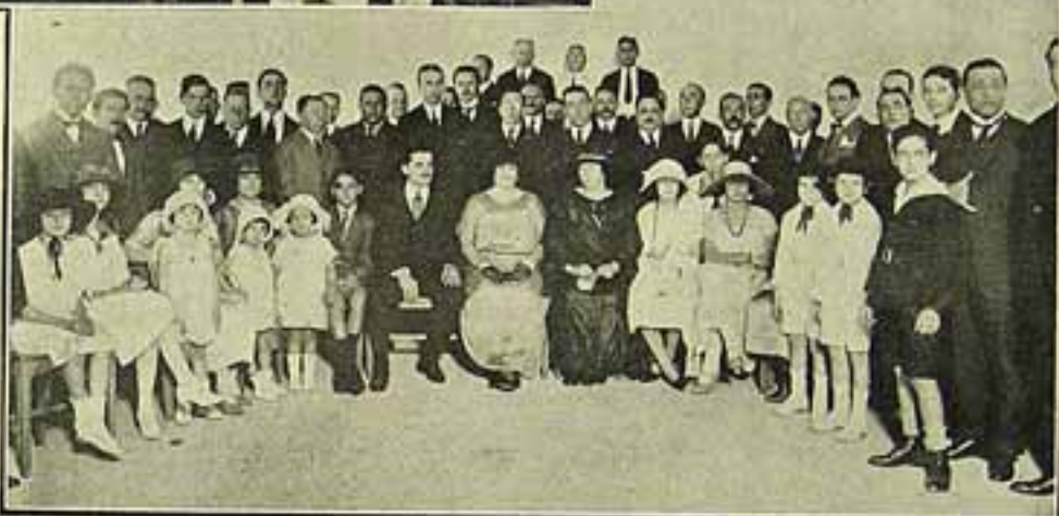
As nossas photographias mostram: 1) Uma vista geral da grande fabrica de moveis dos Srs. Palermo & Cia. 2) Convidados que assistiram ao acto inaugural da fabrica de moveis dos Srs. Palermo & Cia., vendo-se ao centro, rodeado de sua familia e varias senhoritas, o Sr. Palermo.
