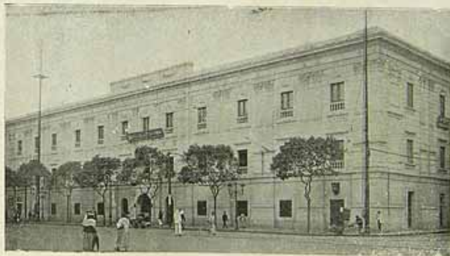
Edifício onde funciona a Academia de Commercio
