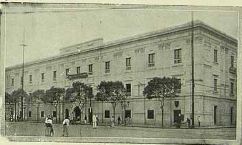
Edifício onde funciona a Academia de Commercio.
