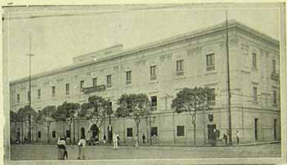
Edifício onde funciona a Academia de Commercio
