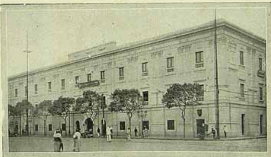
Edifício onde funciona a Academia de Commercio
