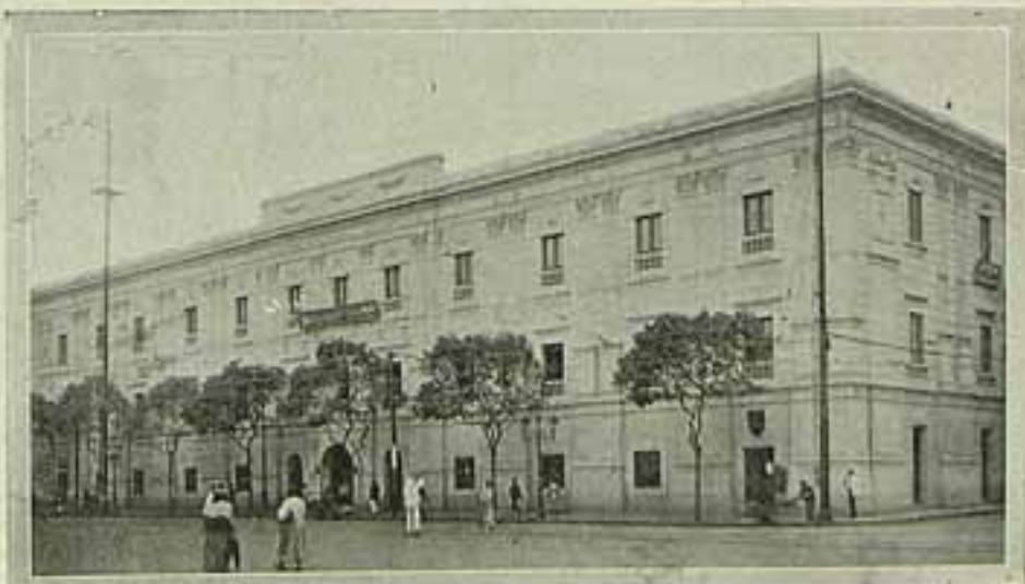
Edifício onde funciona a Academia de Commercio
