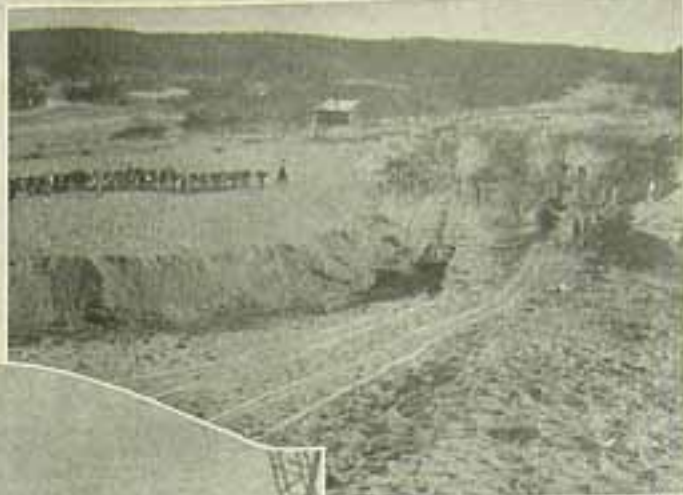
Excavações nas fundações do açude Quixeramobim.
