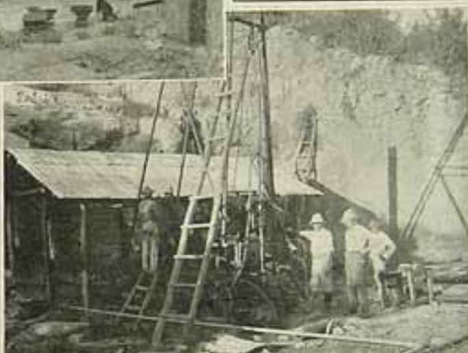
Excavações nas fundações do açude Quixeramobim.
