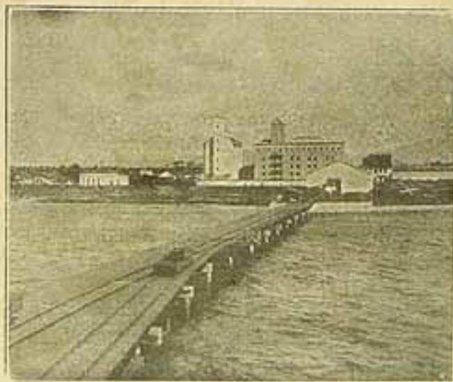
Grande moinho de Trigo construido em Paranaguá, pela firma E. Kemnitz & C., para a S. A. "Moinho Santista" e hoje propriedade das I. R. F. Matarazzo. Esta photographia mostra a linda e solida ponte de atracação de vapores e trafego ferro-viário, toda em cimento armado, e os soberbos silos, que têm uma altura de 35 metros e capacidade para 3.000 toneladas e cujas fundações sobre terreno de lama foram feitas sobre estacas, também de cimento armado, com 18 metros de profundidade.
