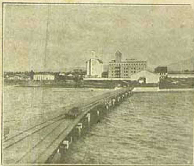
Grande moinho de Trigo construido em Paranaguá, pela firma E. Kemnitz & C., para a S. A. "Moinho Santista" e hoje propriedade das I. R. U. Matarazzo. Esta photographia mostra a linda e solida ponte de atracação de vapores e tráfego ferro-carril, toda em cimento armado, e os soberbos silos, que tem uma altura de 35 metros e capacidade para 3.000 toneladas e cujas fundações sobre terreno de lama foram feitas sobre estacas, tambem de cimento armado, com 18 metros de profundidade.
