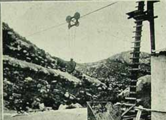
Vista de Gargalheira — 1) Estrada de acesso ao local da represa e estrada para Acary, ao fundo, 2) Um trecho do rio Acanã, cujas águas represará açude Gargalheira, 3) Cabo aereo para o transporte do material destinado à barragem, 4) Ponte de cimento armado, em construção sobre o leito do rio Curraes Novos, 5) Trecho da estrada
