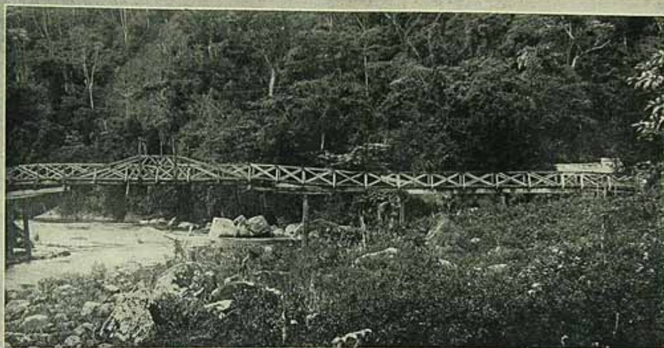
Ponte sobre o rio Macahê ligando o Municipio da Barra de S. João ao de Macahê, construida pela actual administração.
