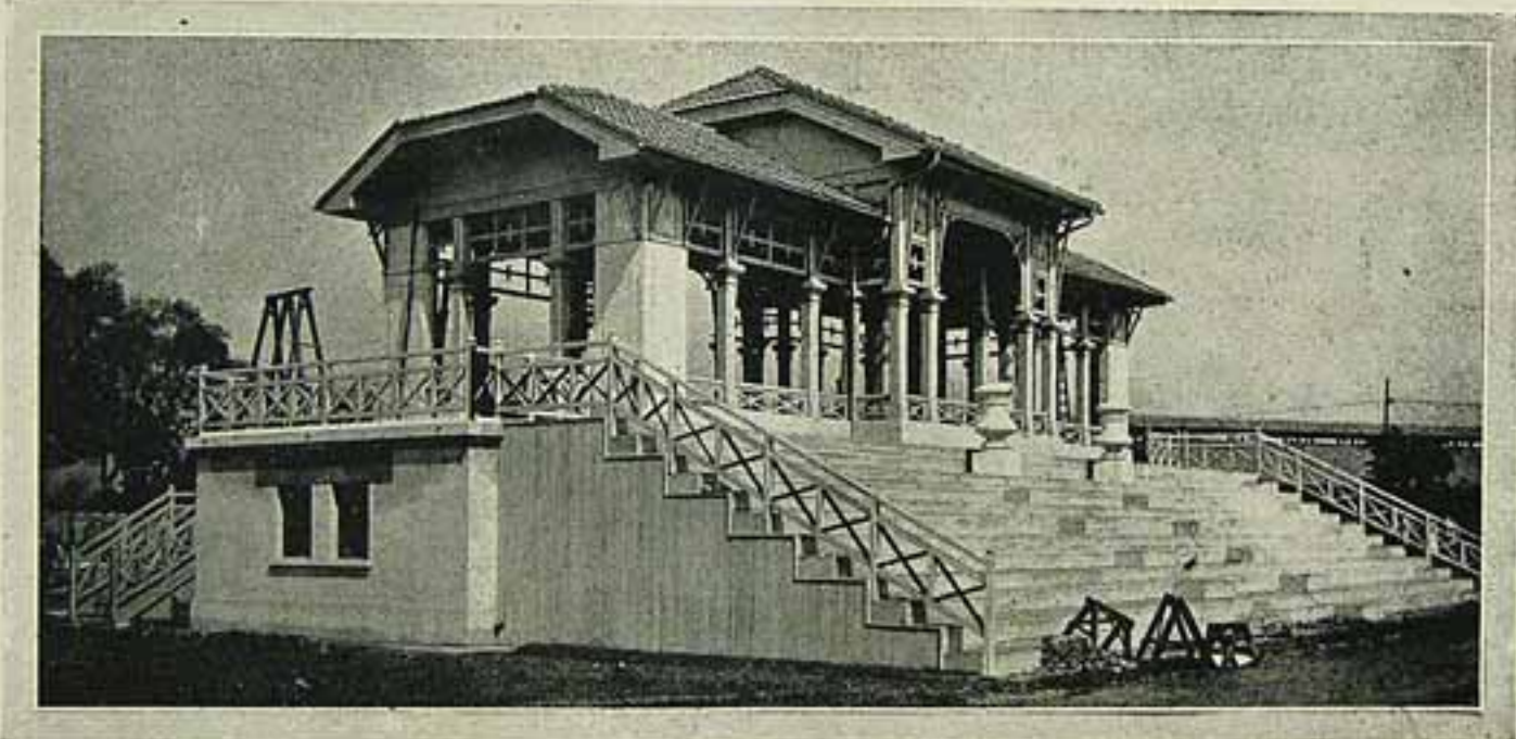
Archibancada de honra, na Exposição Internacional de Pecuária, installada nos terrenos da Directoria de Industria Pastoral, á rua Malta Machado.
