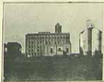
Importante obra realisada pela firma E. Kemnitz & C., em Paranaguá, para a S. A. "Moinho Santista". Os Silos de Trigo, em cimento armado com 35 metros de altura e capacidade para 3.000 toneladas, foram construidos sobre terreno de lama, tendo as fundações 15 metros de profundidade.
