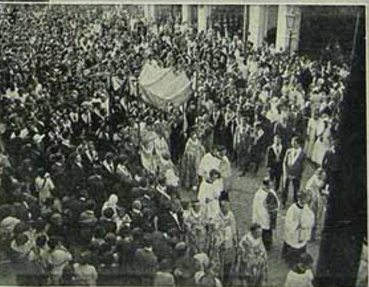
nas gravuras acima trechos da procissão atravessando as ruas centraes da cidade e da multidão que a acompanhava.
