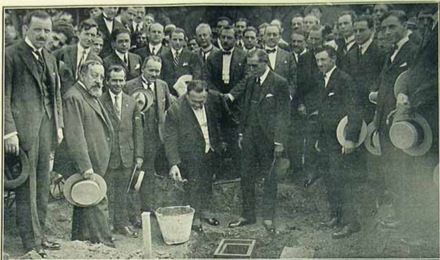
Lançamento da pedra fundamental do Pavilhão dos Estados Unidos do Mexico, ha días realizada, na Avenida das Nações
