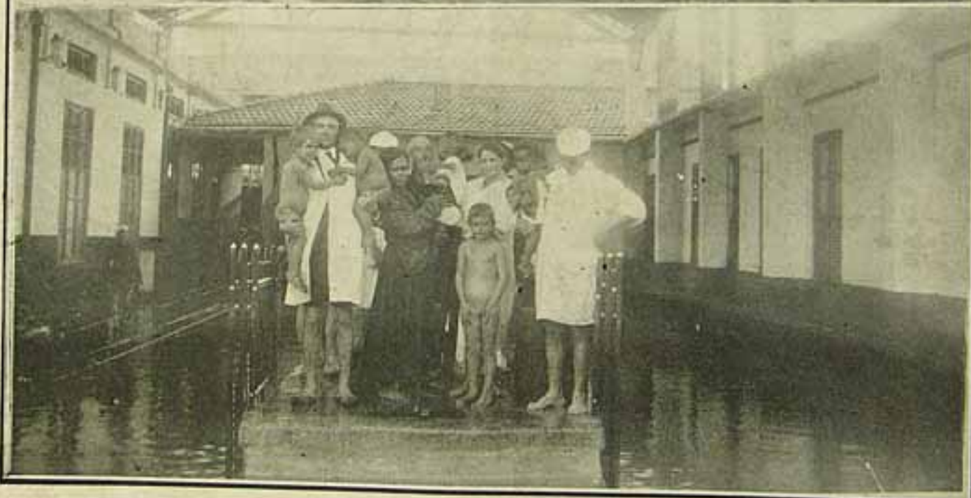
Aspectos do populoso bairro de S. Christovão, na inundaçào de domingo. Em baixo:—Uma família inteira difficilmente salva das aguas que lhe invadiram a residencia.
