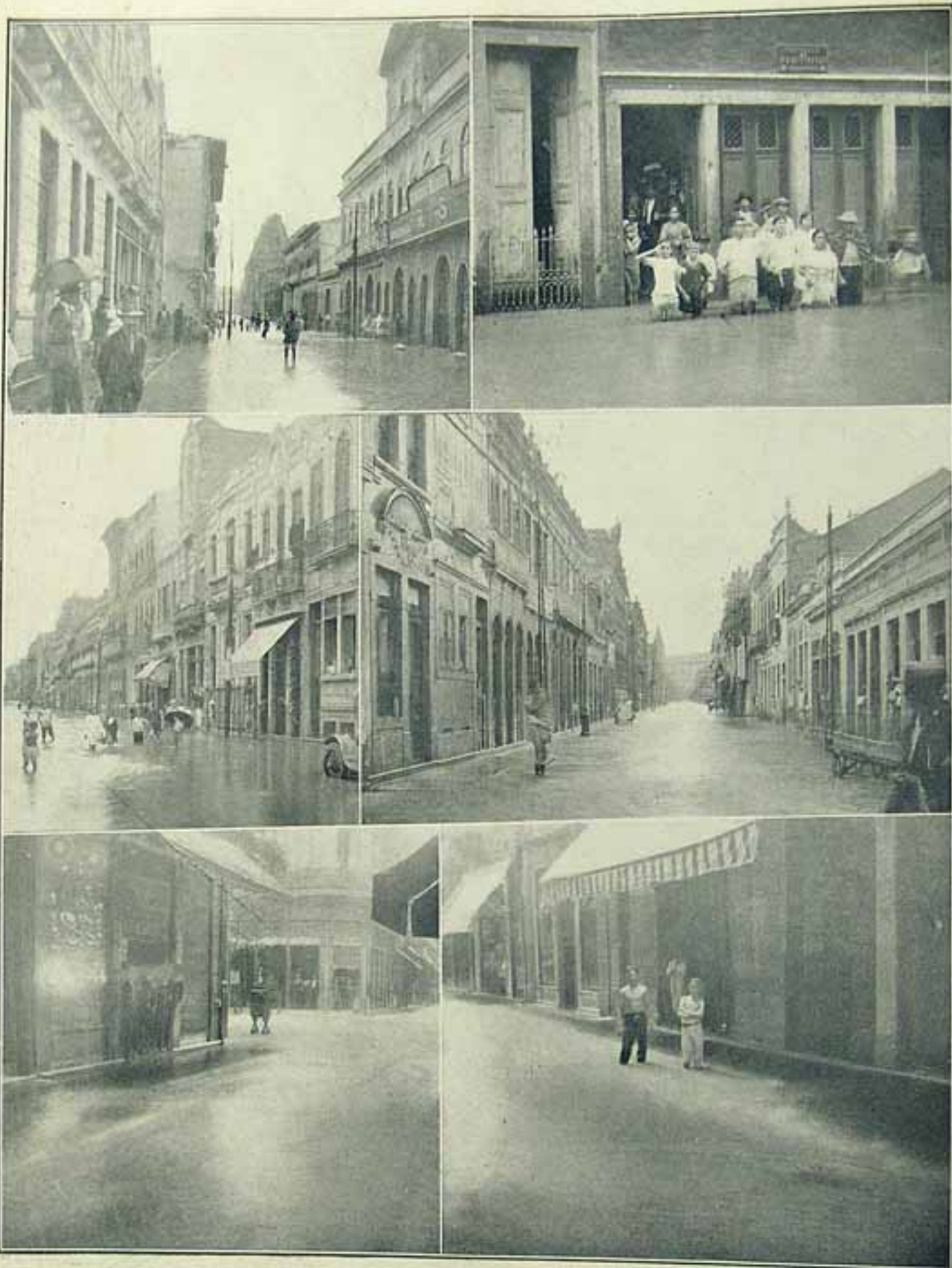
Trechos das ruas dos Invalidos, Lavradio, Uruguayana e Ouvidor, transformados em caudalosos rios, com o ultimo temporal.
