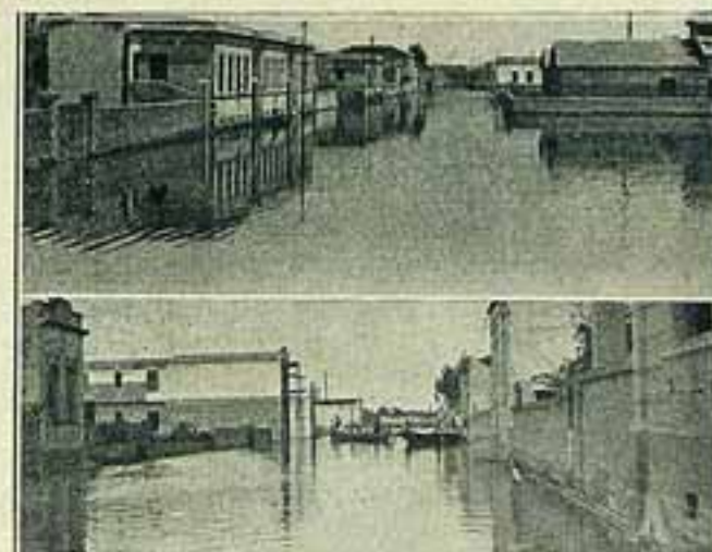
No bairro da Ponte Grande — Aspectos das ruas inundadas pelo Tietê.
