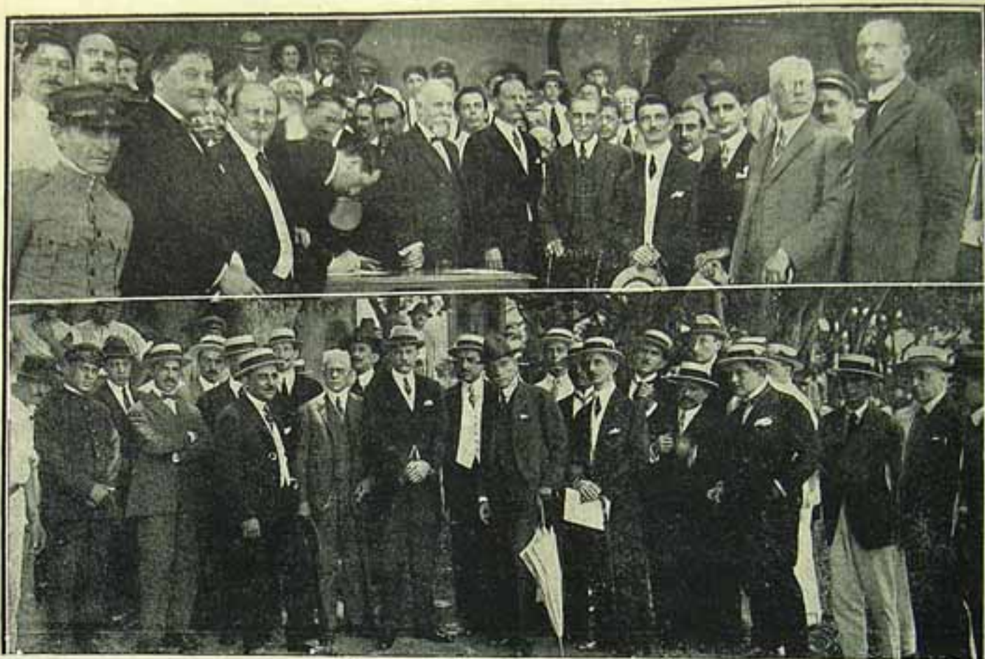
Na cerimonia do lançamento da pedra fundamental do Palácio da Belgica na Exposição do Centenario. Em cima, a assignatura da carta. Em baixo as Srs. Embaixador Belga e prefeito Municipal no local em que se está construindo o Palácio, na Avenida das Nações.
