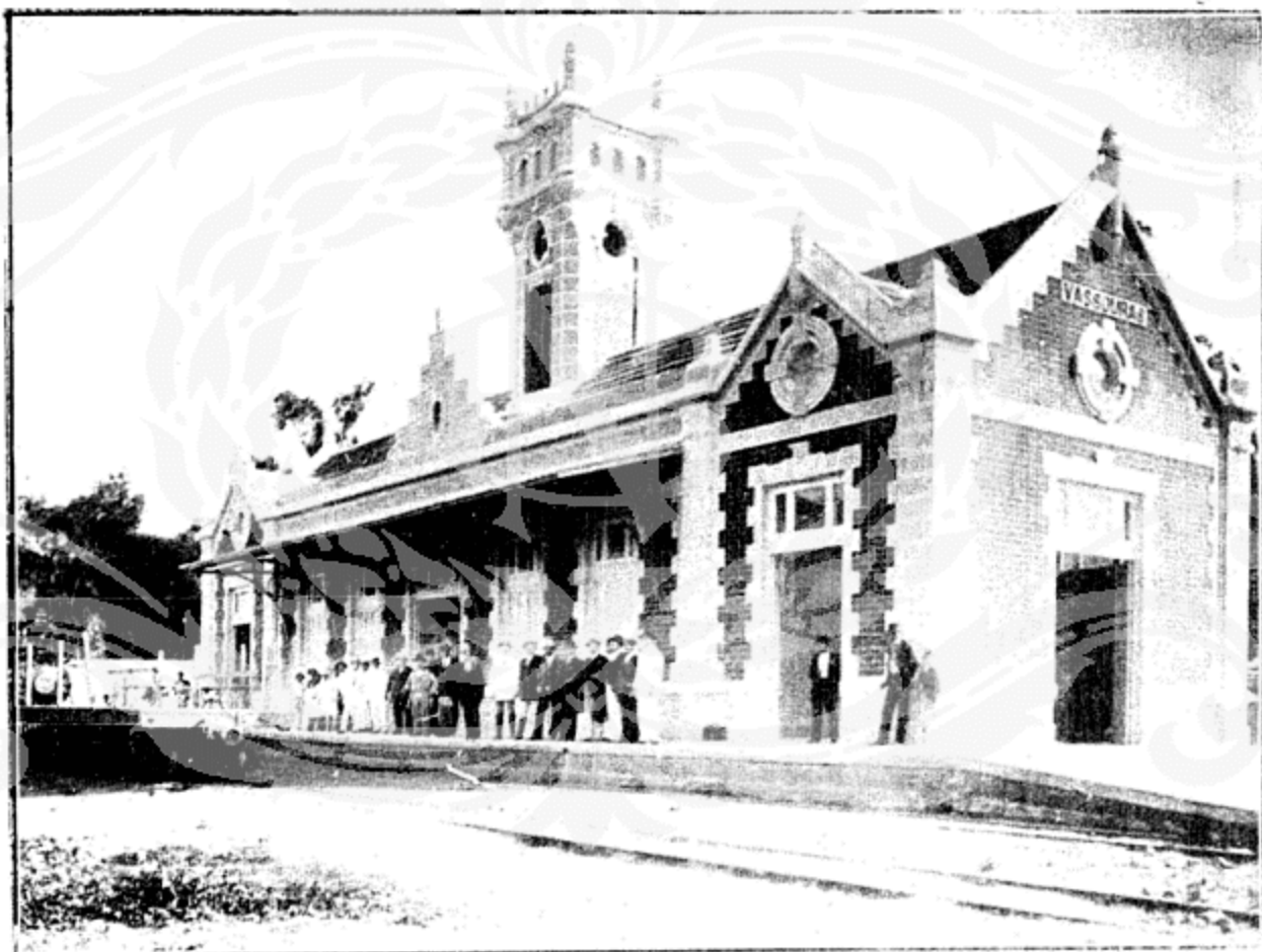
Photographia da nova Estação da cidade de Vassouras, na linha de Vassouras a Portella.
