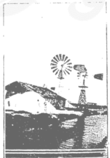
Moinhos de vento, que movimentam as águas das salinas, junto de um monte de sal.
