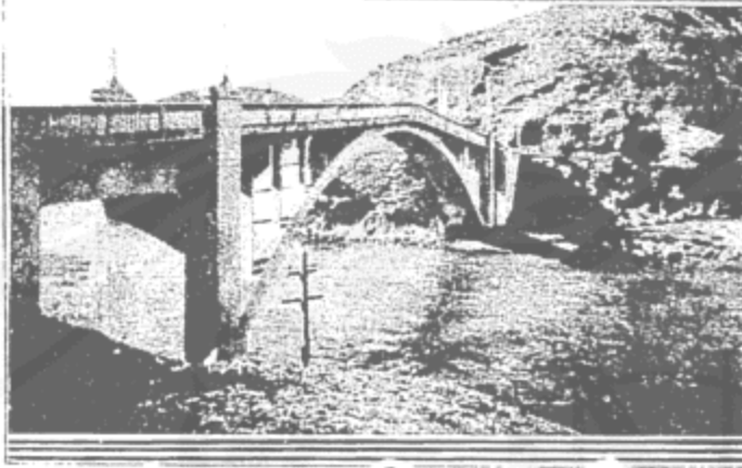
Ponte que liga as duas margens da lagôa, dando acesso por terra à cidade.
