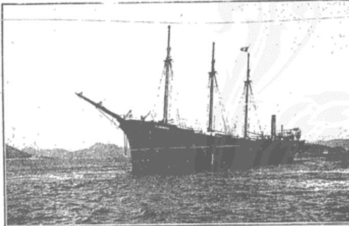
O navio-motor Itamaracá , completamente remodelado nos conhecidos estaleiros da Ilha do Vianna, transformado num cargueiro sólido e de linhas elegantes, tendo 3 masts e 2 motores suíços Sulzer-Diesel, consumindo óleo bruto, cada um com 300 cavallos effectivos
