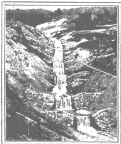
Uma cascata de alvenaria
