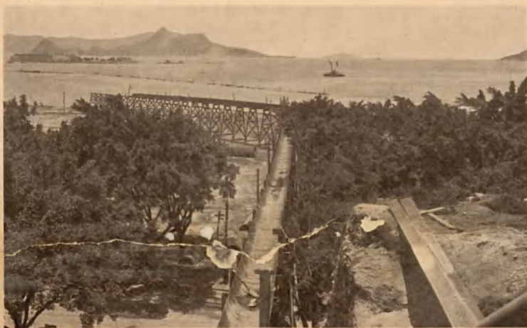
DESTRUCTION DU MORRO DO CASTELLO Remblai de la plage de Santa Luzia, 25 janvier 1922
