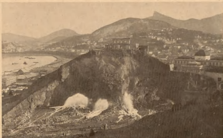
DESTRUCTION DU MORRO DO CASTELLO Les water-guns, vue prise le 9 octobre 1922
