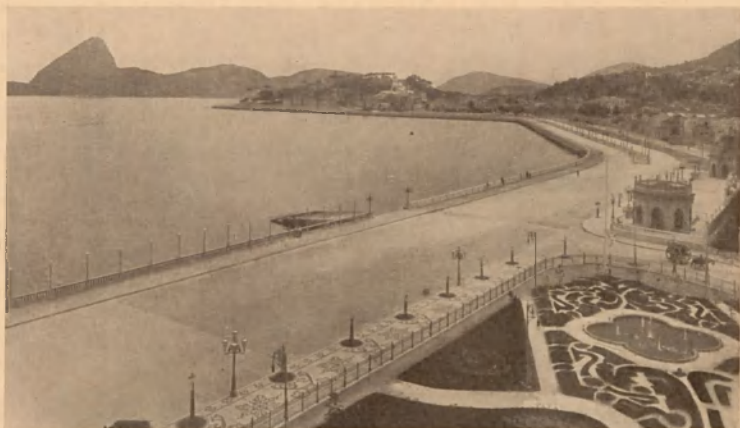
L'AVENIDA BEIRA MAR . CRÉATION DU QUAI DE LAPA Vue prise le 21 décembre 1906
