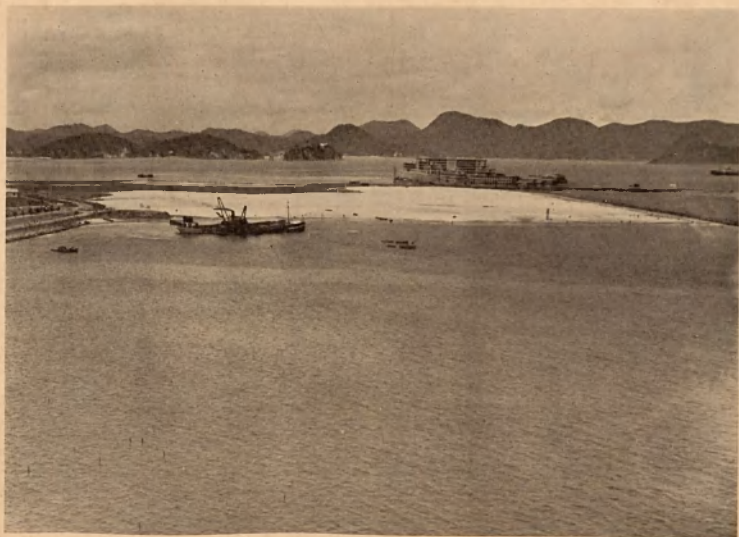
L'AÉROPORT SANTOS-DUMONT EN CONSTRUCTION A GUANABARA Les remblais entre le Calabouço et Villegagnon Vue prise vers Nietheroy, fin 1936
