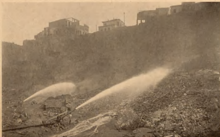
DESTRUCTION DU MORRO DO CASTELLO Les water-guns, vue prise le 30 août 1922
