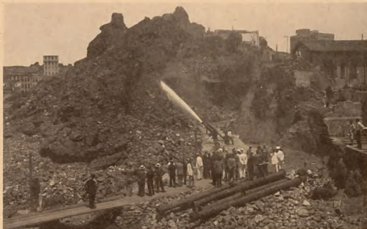
DESTRUCTION DE LA PARTIE ARRIÈRE DU MORRO DO CASTELLO Vue prise le 11 novembre 1928
