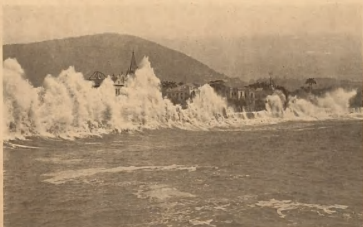
Immeubles devenus l'ambassade de France
