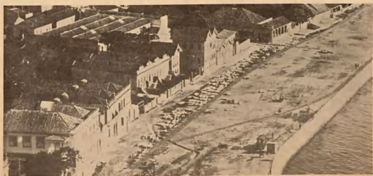
+ BÂTIMENT EXISTANT ENCORE AU CENTRE DE L'AMBASSADE DE FRANCE Agrandissement de la vue de 1906
