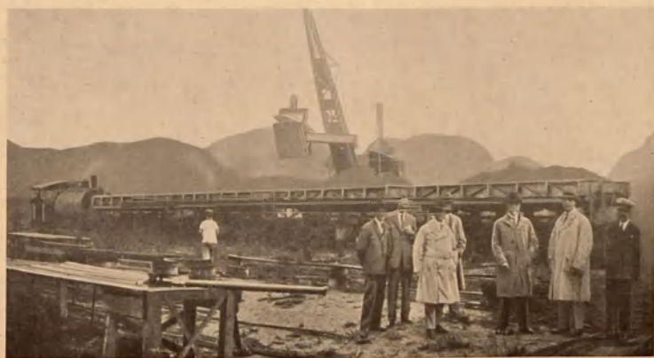
DESTRUCTION DE LA PARTIE ARRIÈRE DU MORRO DO CASTELLO L'architecte Agache, le président de la république Washington Luiz, le préfet de Rio Antonio Prado Vue prise au début de mai 1928
