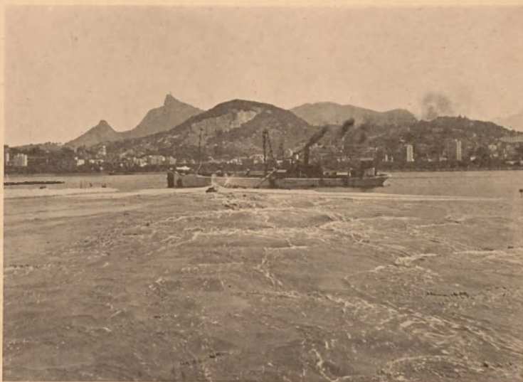
L'AÉROPORT SANTOS-DUMONT EN CONSTRUCTION A GUANABARA
