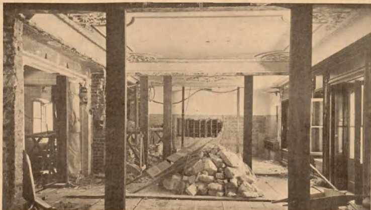
CONSTRUCTION DE LA GALERIE INTÉRIEURE DU REZ-DE-CHAUSSÉE FAITE DE JUIN A AOÛT 1936
