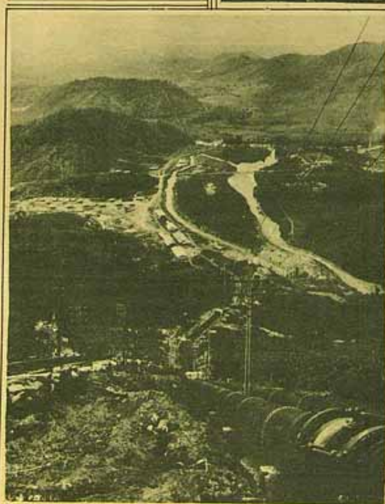
Abaixo da cota 350 — Canos adductores e Casa de Força. Ao fundo, a ilha de São Vicente.
