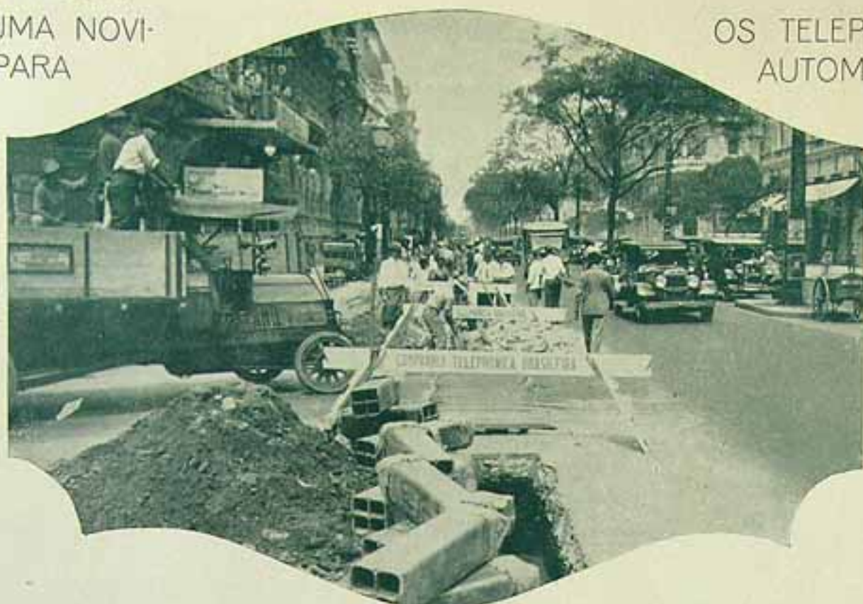
Instalação subterranea na Avenida Rio Branco
