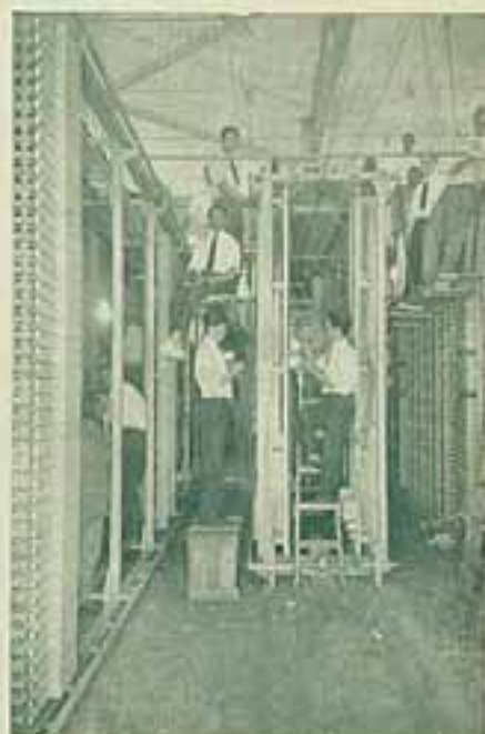
Vista do equipamento da nova estação automatica durante a instalação.
