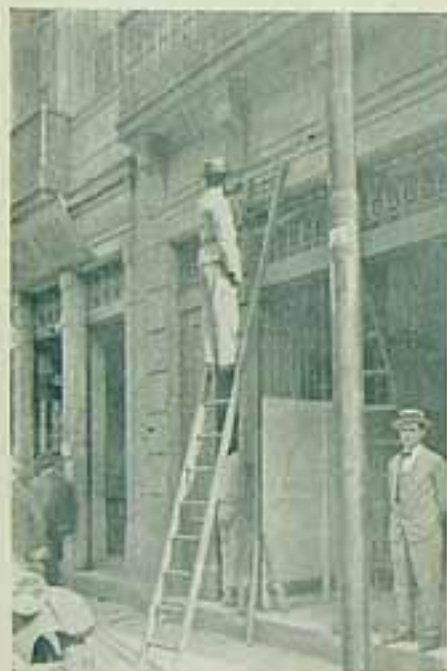
Detalhe do serviço de instalação de telephone: collocando um anel na parede externa de um prédio para passagem de fios.
