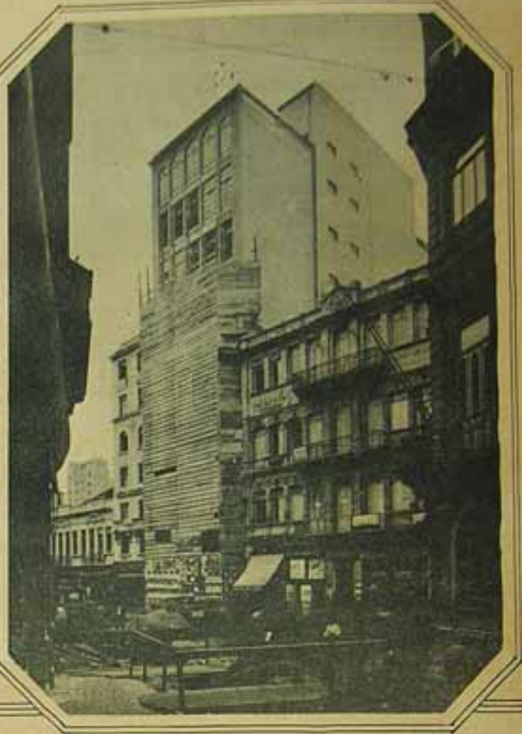
Dois modernos "sky-scrapers", — os predios Byington (em acabamento) e Mario Figueiredo, projecto e construção dos engenheiros Rangel Christoffel & Cia., situados à rua Alvarez Penteado, vendo-se um trecho dessa via publica entregue aos serviços da pavimentação.
