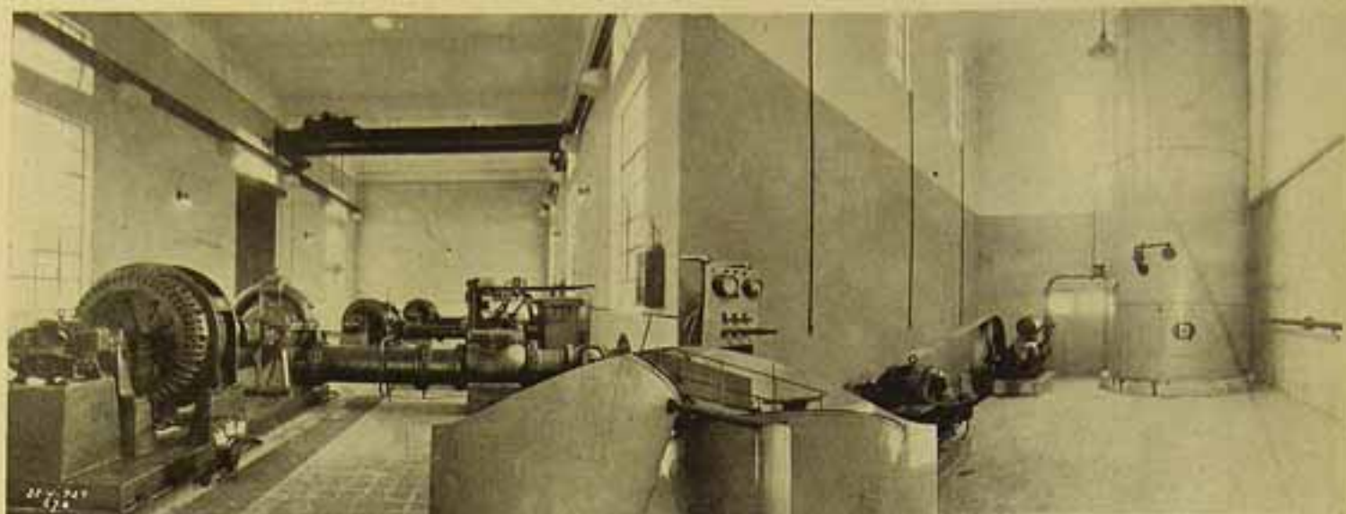
Interior da estação elevatória.
