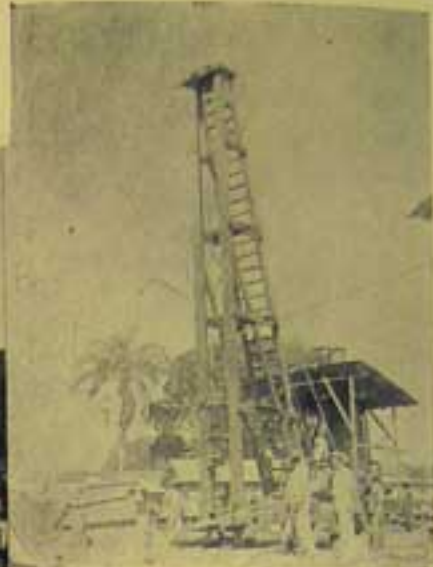
A grande machina bate-estacas de cimento armado.
