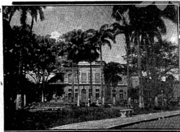
Edifício da Escola Normal.
