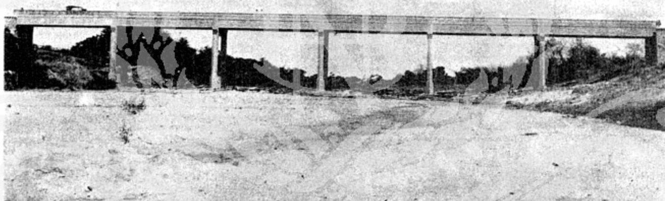
Obras do Nordeste — Ponte de concreto armado, sobre o rio Purús, no Ceará, com 90 metros de vão, já construída.
