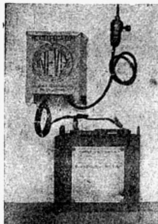
O Rectificador "Neva" carregando uma bateria de 6 volts.
