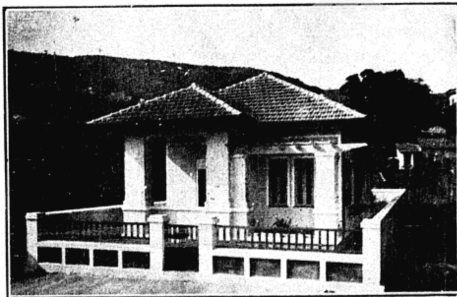
Bungalow construido em Real Grandeza. Projecto e construção de Freire & Sodré, engenheiros, com escriptorio á rua de S. José 21 (2º) C. 4709. Instalação electrica de Teixeira, Pinto & C., rua Rodrigo Silva 16.
