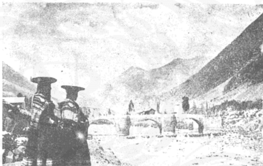
CUSCO — Ponte sobre o torrentoso rio Urubamba, na parte larga do vale. Suas águas desembocam no rio Amazonas.
